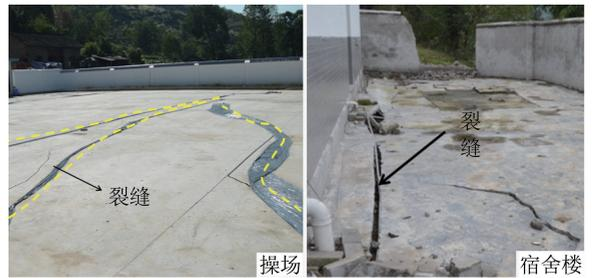
图3 定东小学操场和宿舍楼裂缝
